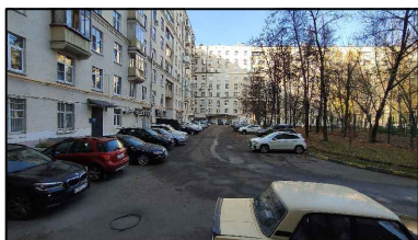
Подъезд №12-Камера №6 (ТСЖ-Проектная)
