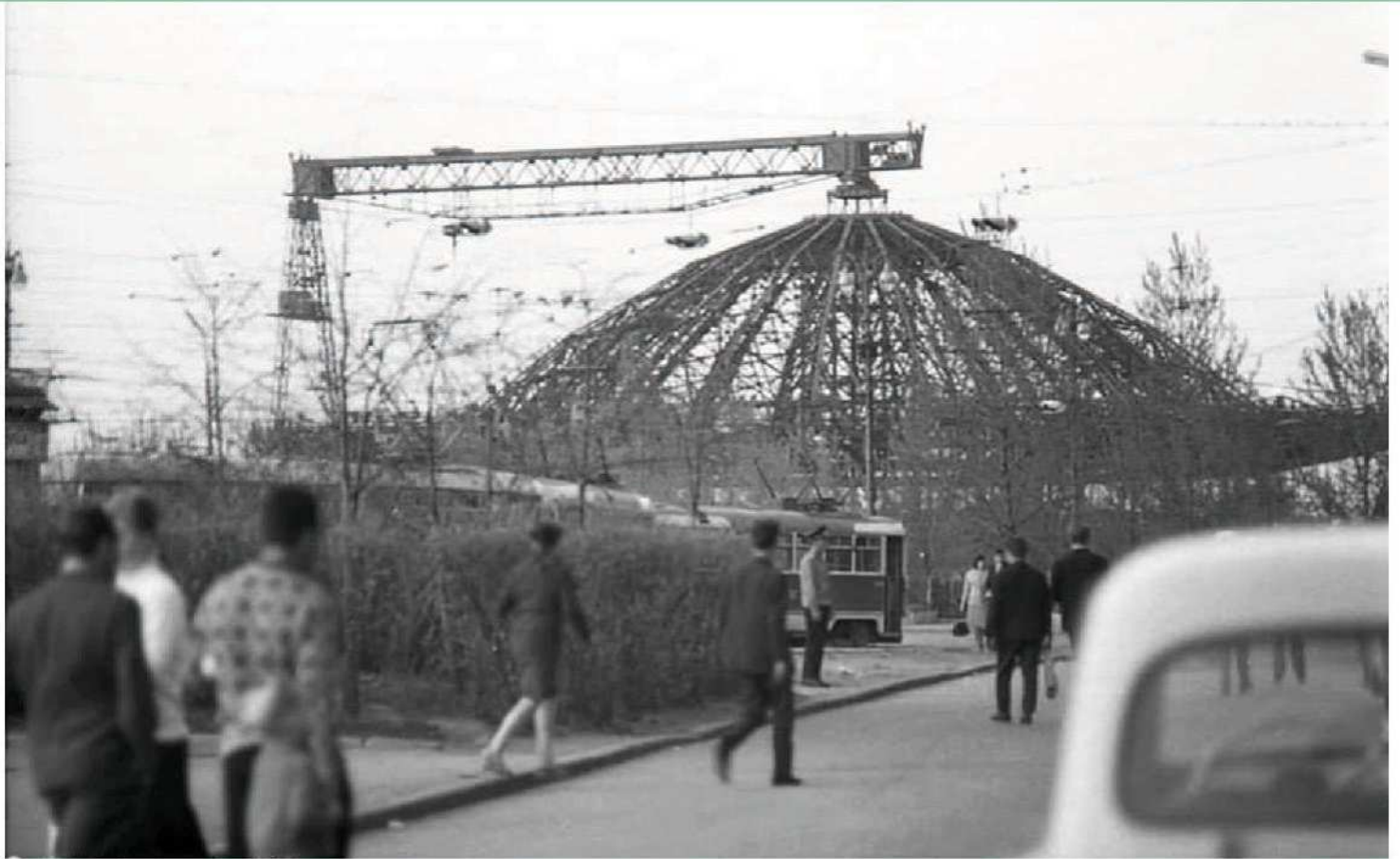
1967 г. Возведение купола Большого Московского цирка
