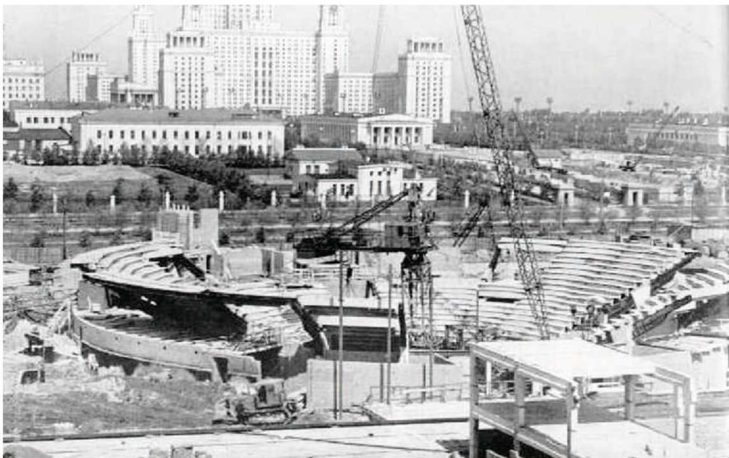
1966 г. Строительство Большого Московского цирка
