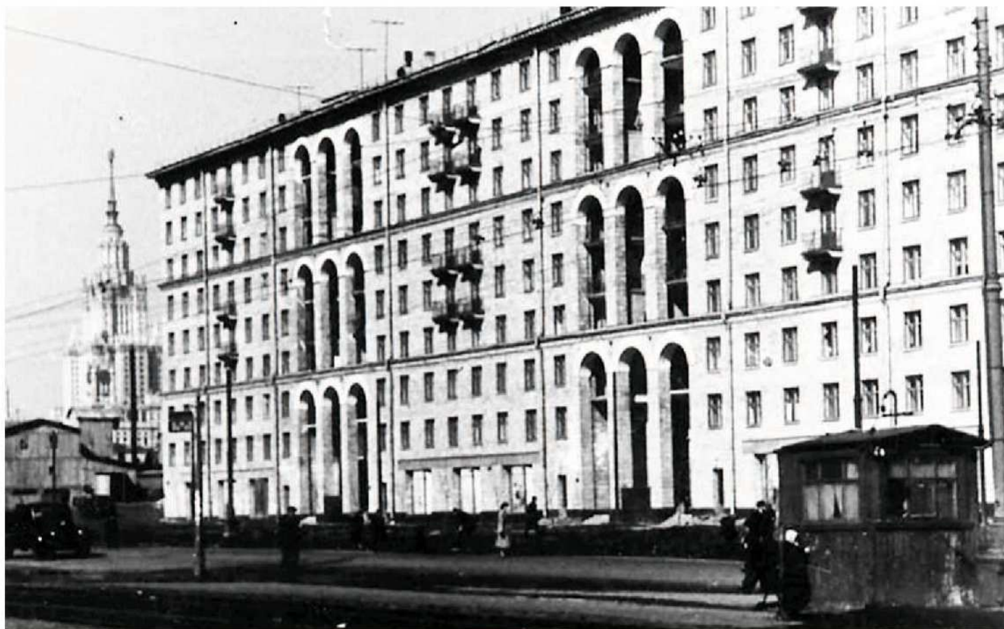
1957-1958 гг. Вид на дом 18 с Ломоносовского проспекта
