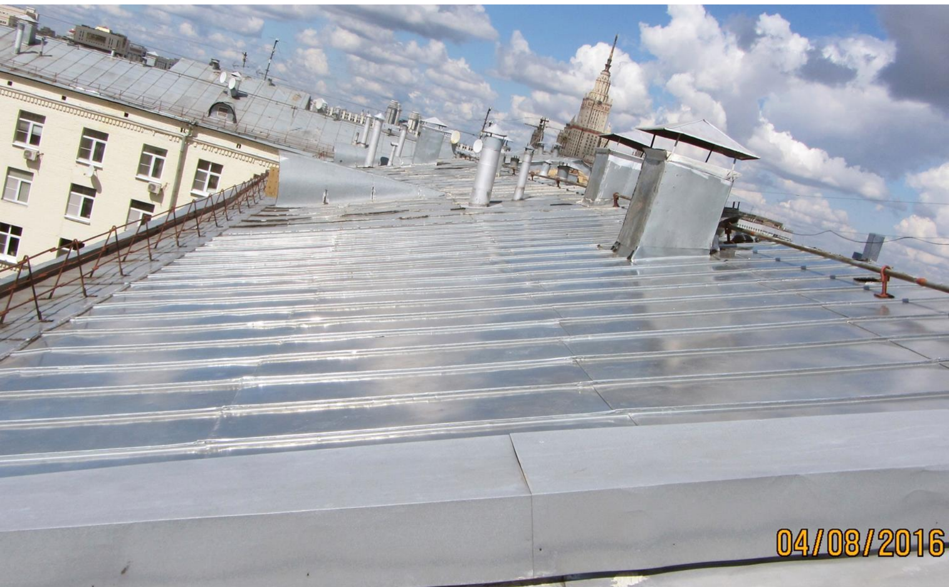
2016 г. Новая кровля над 3-м подъездом
