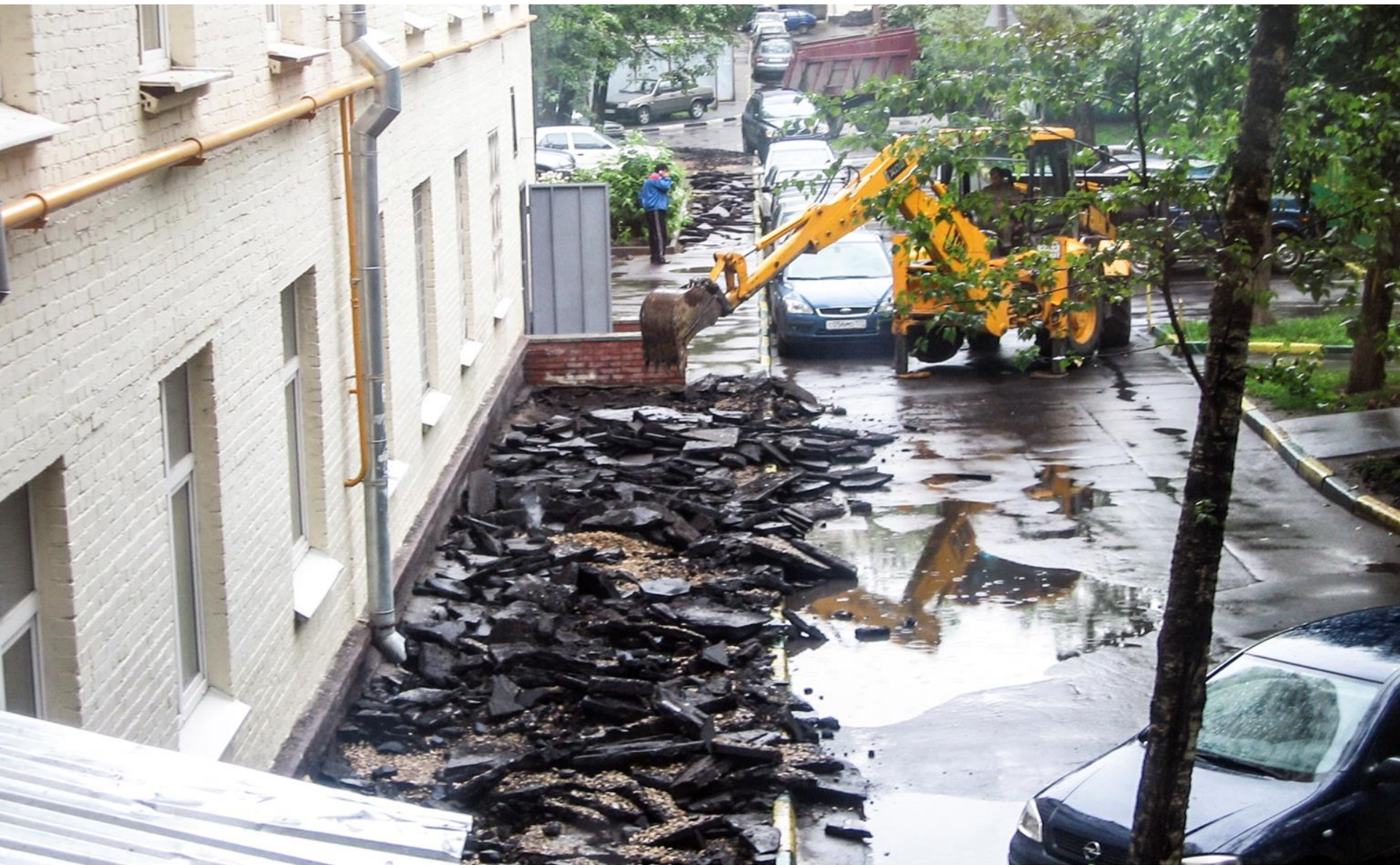
2006 г. Ремонт тротуара во дворе в рамках капремонта дома
