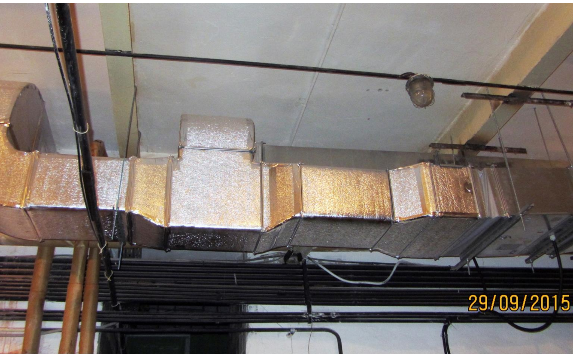
2015 г. Новая вентиляция в ИТП
