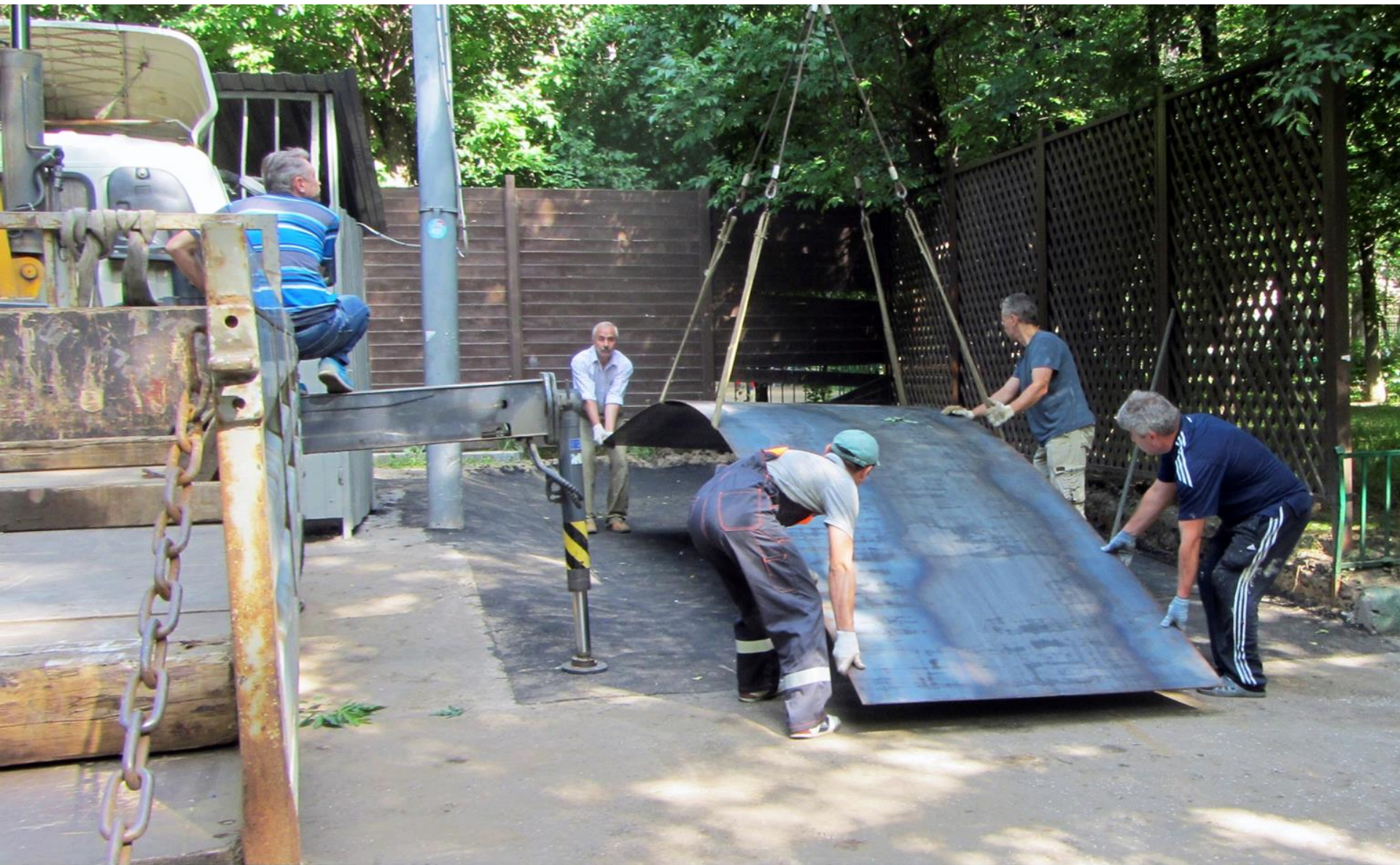
2016 г. Укрепляем площадку
