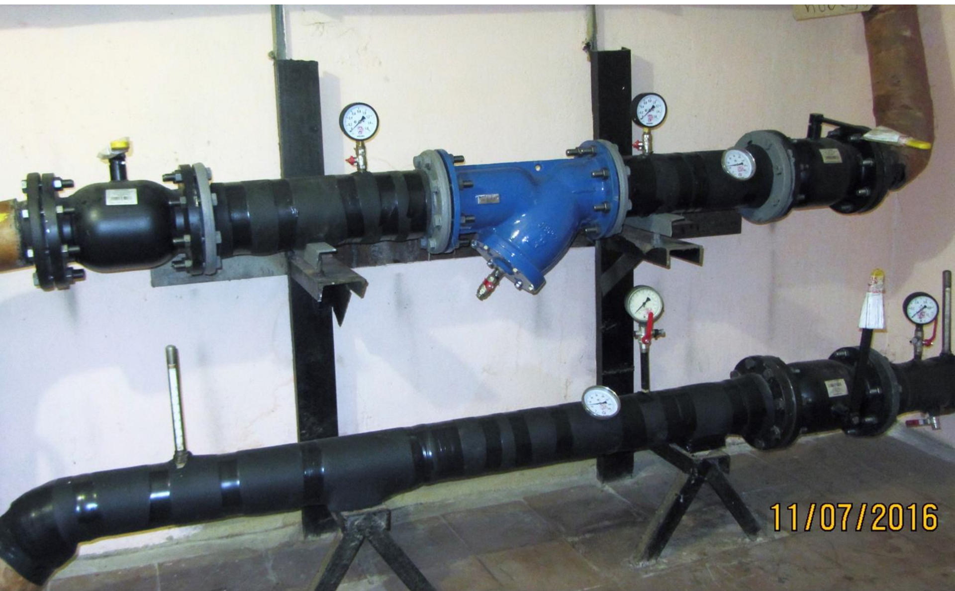
2016 г. Тепловой узел после реконструкции
