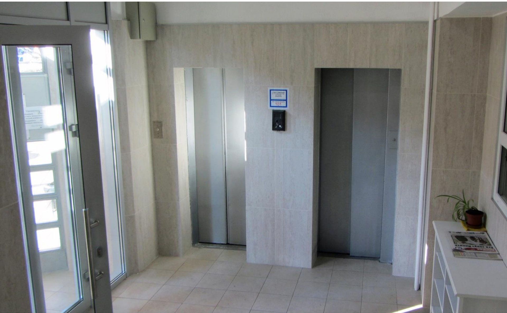
2015 г. Холл 10-го подъезда после ремонта
