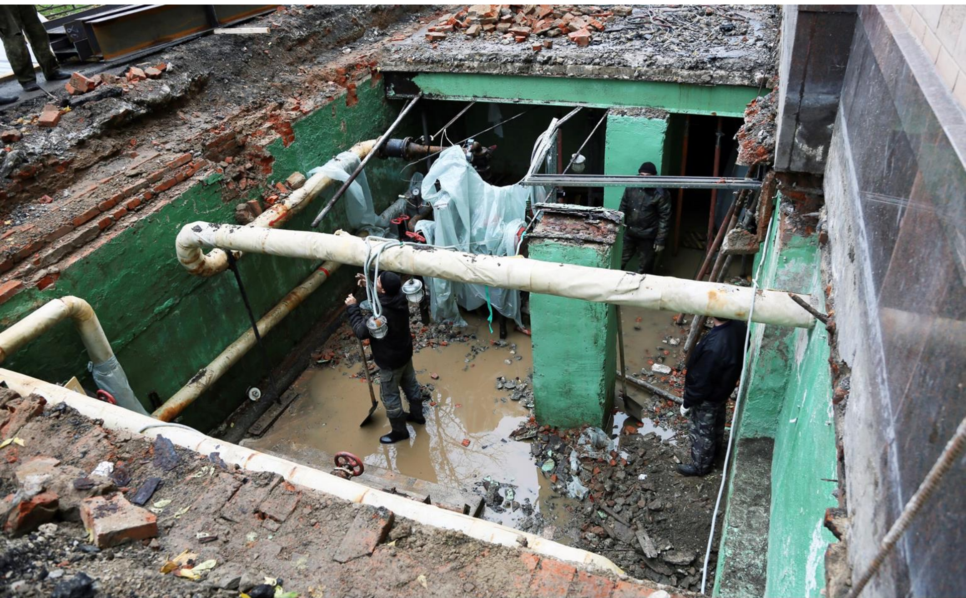
2012 г. Замена перекрытий в ИТП дома
