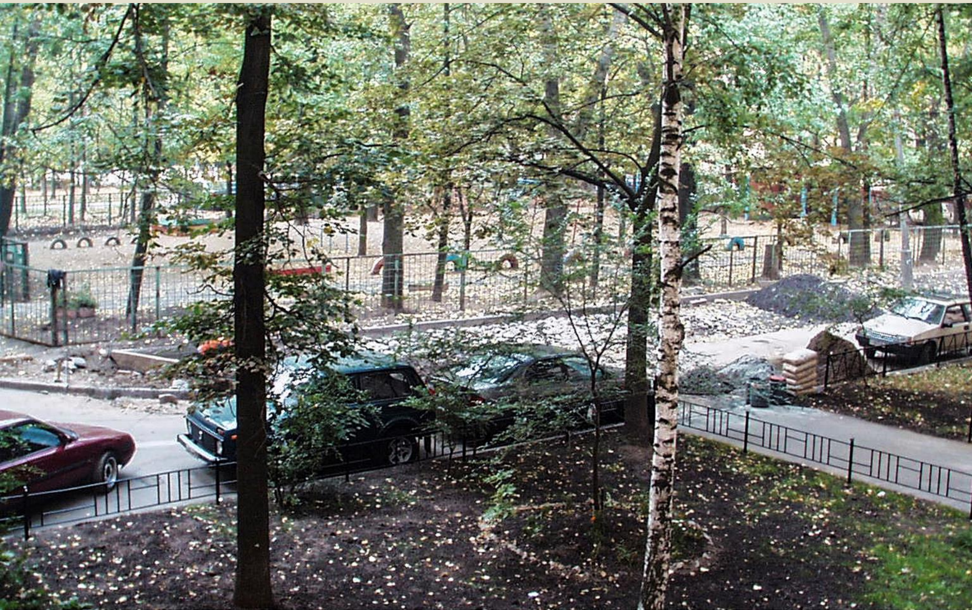
2000 г. Строительство парковки напротив 3-4 подъездов Фото Б.О. Барбараша, личный архив
