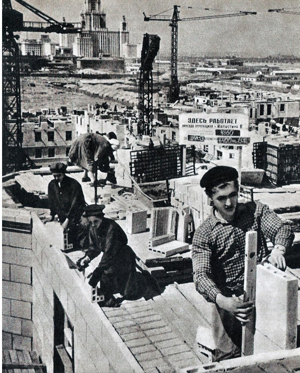
1953 г. Строительство дома преподавателей (дом 14 по Ломоносовскому) Фото из книги «Любимый город», изд. «Московский рабочий»
