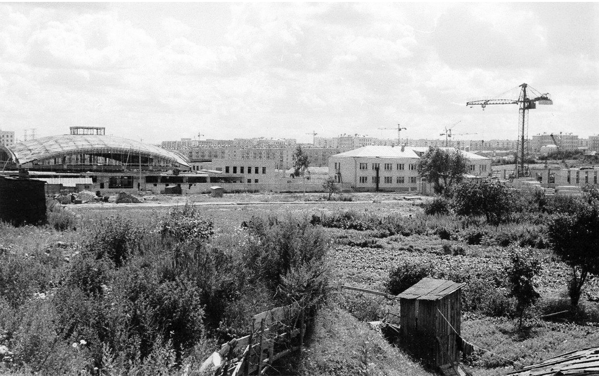
1960-1963 гг. Строительство Черёмушкинского рынка Фото В. Волкова, личный архив
